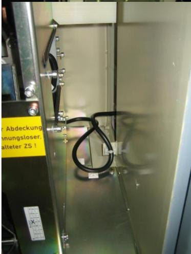
Legen Sie das ZS - Anschlusskabel in einer Kabelschleife links neben die Trenn- und Erdungseinrichtung, ähnlich dem Wagenanschlusskabel WA auf der rechten Seite und befestigen Sie es mit Kabelbindern.
